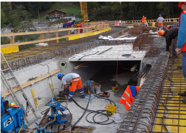
Erstellung des Brückenüberbau
