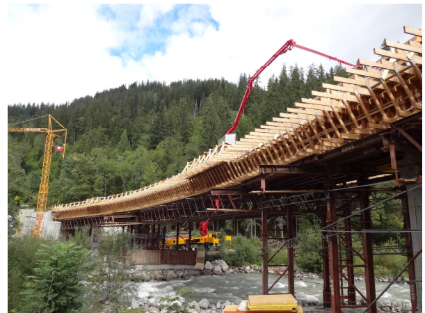
Lehrgerüst über die Simme
