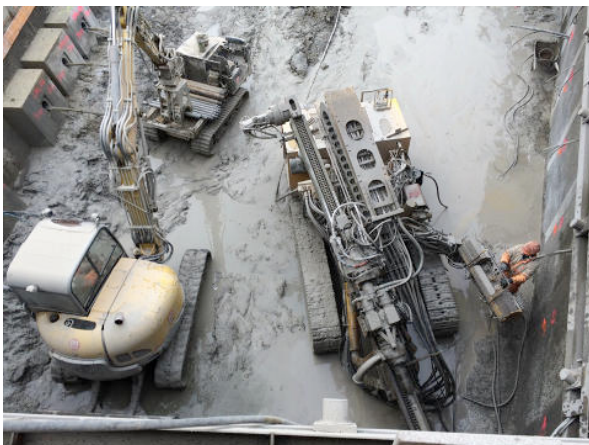
Spezialbohrgerät im Einsatz
