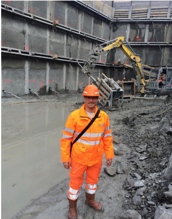
Rühlwand „Tagbautunnel Ost“, Eppenberg
